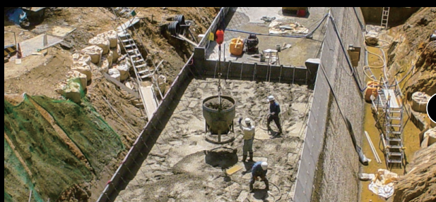
05: コンクリート打設状況
