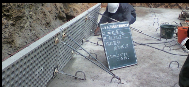
01: 1段目組立状況
