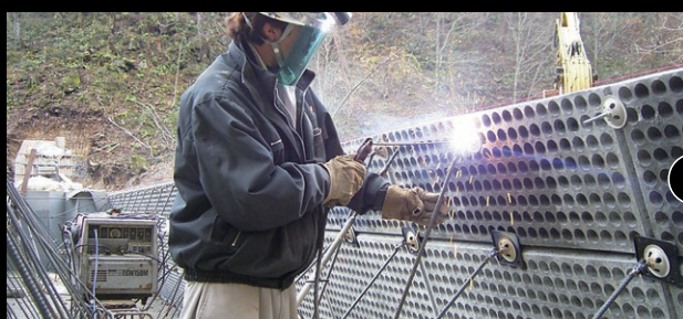
03: セパレーター溶接状況
