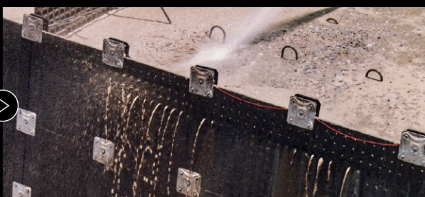
06: グリーンカット状況
