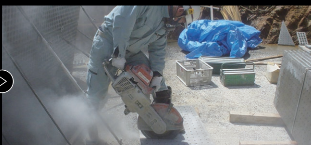
04: 型枠パネル切断加工状況
