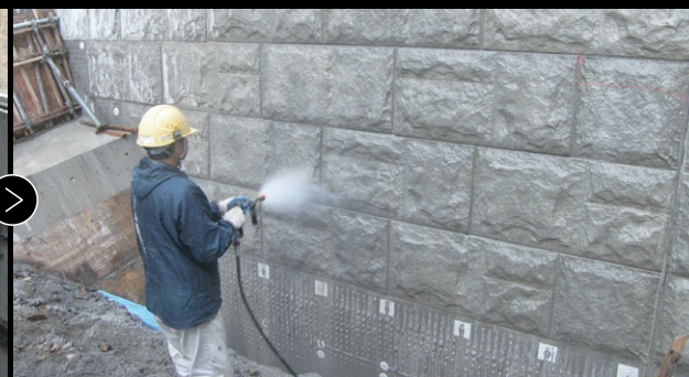
06: 打設後、洗浄状況
