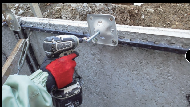
03: 専用組立部材取付状況
