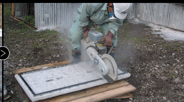
04: 型枠パネル切断加工状況
