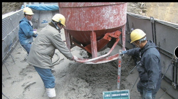
05: コンクリート打設状況
