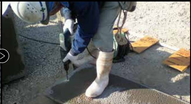
04: 補強金具取付穴加工状況
