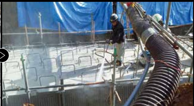
06: グリーンカット状況
